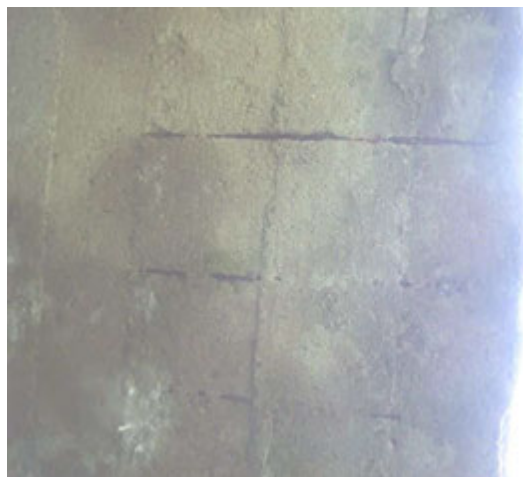
Obr. 18: Koroze výztuže na kraji NK, výluhy sintru.
