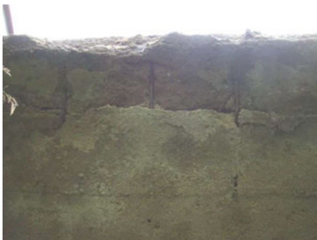
Obr. 19: Degradovaný konec nosné konstrukce.
