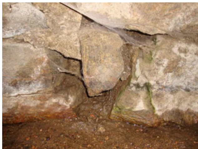
Obr. 10: Uvolněný kámen v opěře, chybějící spárování.
