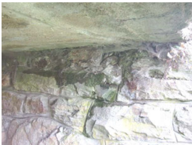
Obr. 21: Zatékání na NK a opěru.
