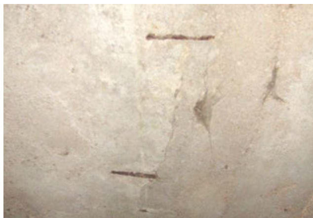
Obr. 14: Mokrý trhlinka v nosné konstrukci, odhalená výztuž.
