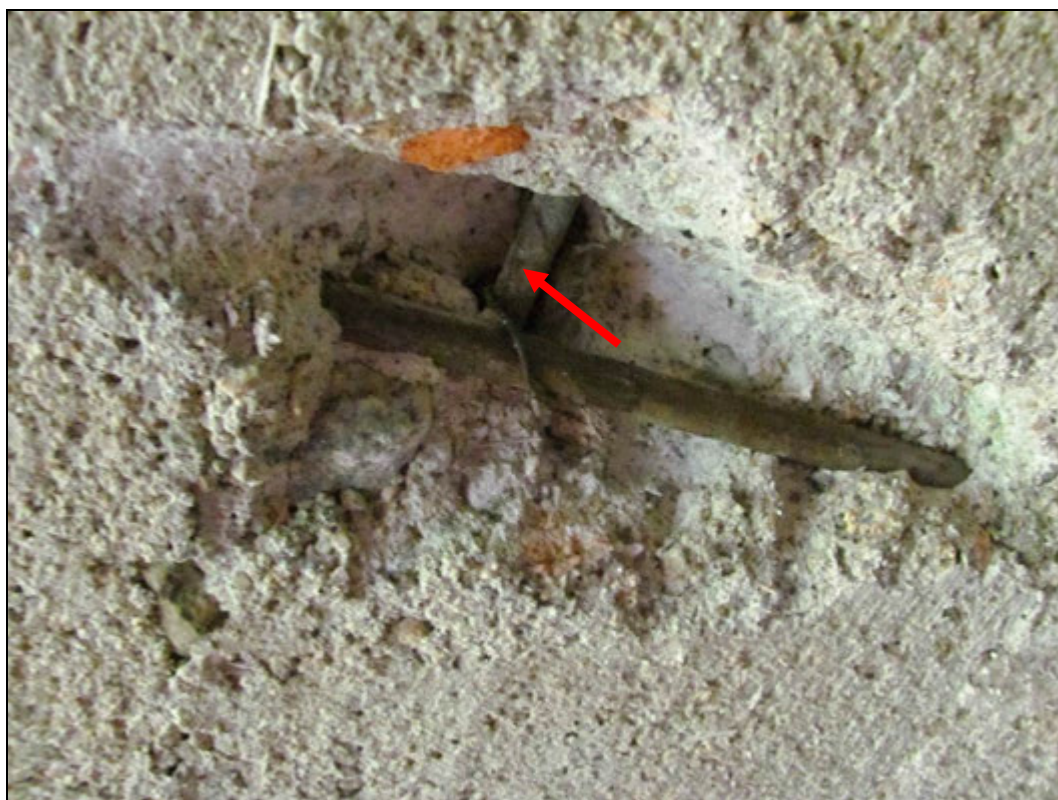
Foto 4: Detail sondy k zjištění stavu betonářské výztuže. Sonda SV3. Bez koroze.
