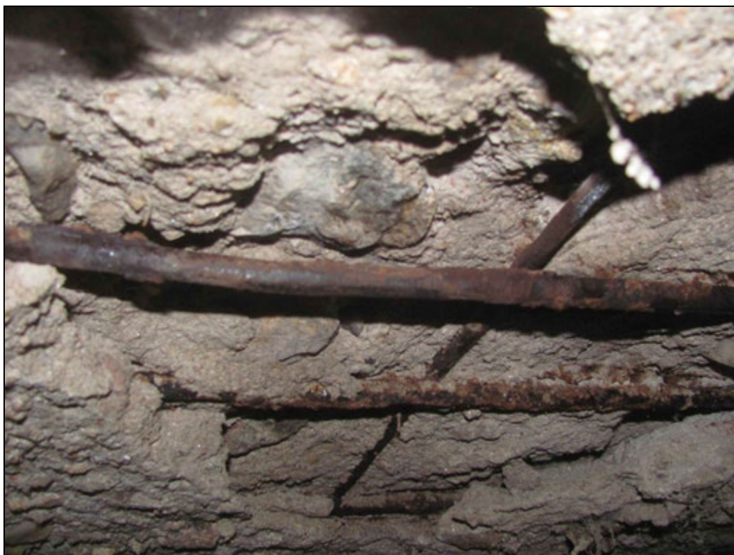
Foto 3: Detail sondy k zjištění stavu betonářské výztuže. Sonda SV2. Povrchová až silná korozí výztuže.
