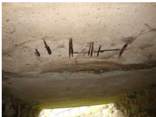
Obr. 14: Mokrý trhlinka v nosné konstrukci, odhalená výztuž.
