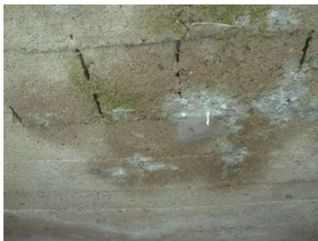
Obr. 20: Výluh sintru, koroze výztuže, zatékání.
