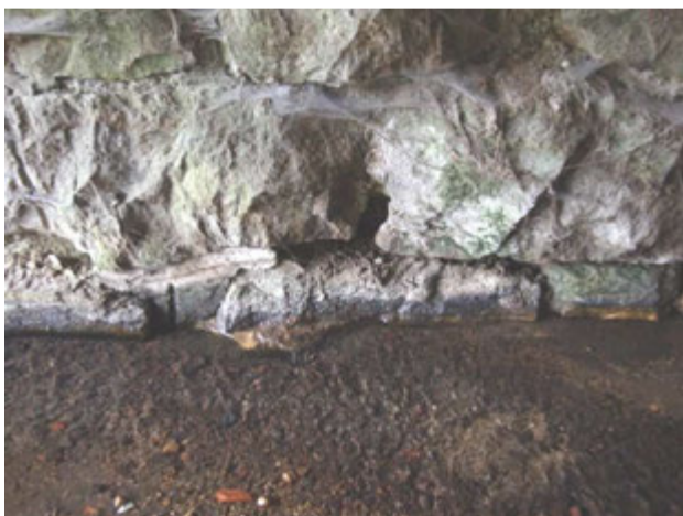
Obr. 9: Chybějící spárování opěry.
