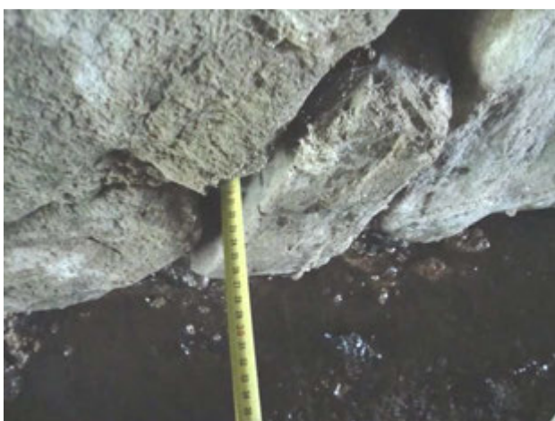
Obr. 11: Chybějící spárování do hloubky 20 cm.
