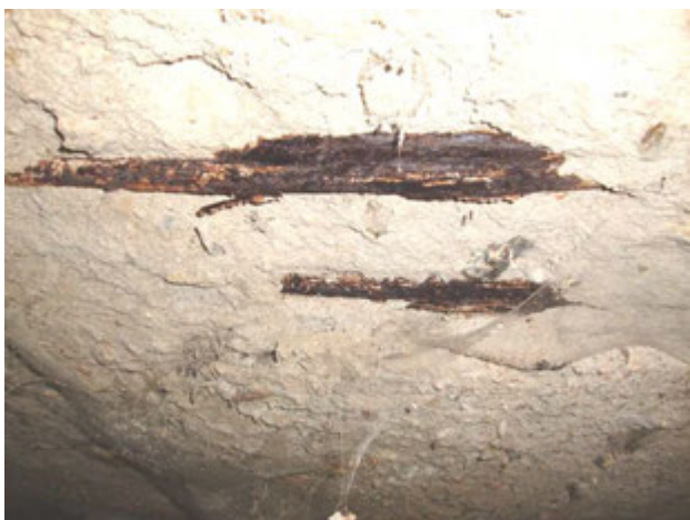
Obr. 15: Koroze nosné konstrukce.
